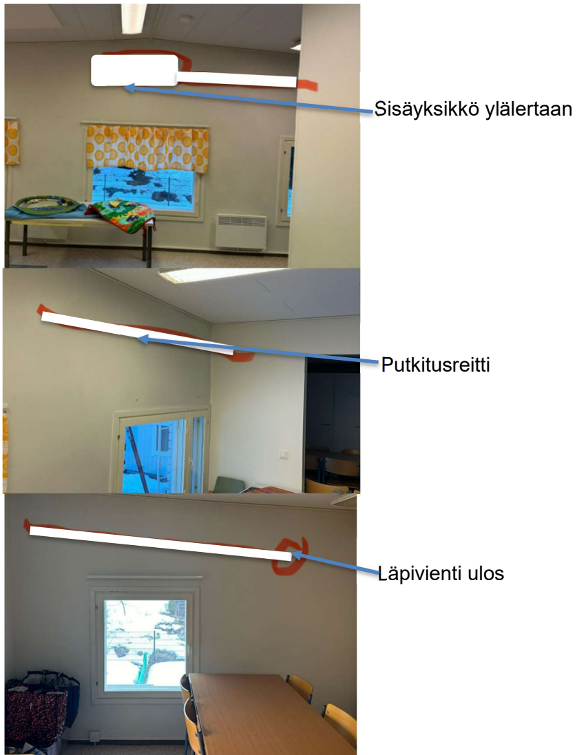
Kuva 7. Sisäyksikkö ja kaapelireitti yläkertaan
